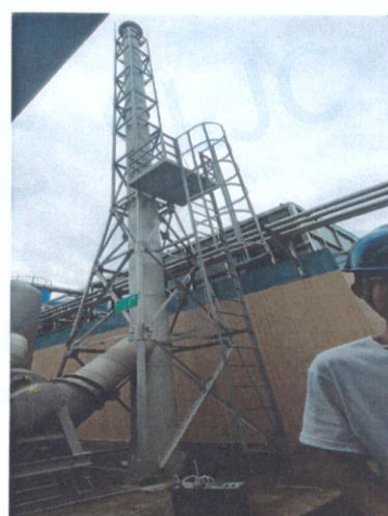
污水处理站排气筒出口 07#
